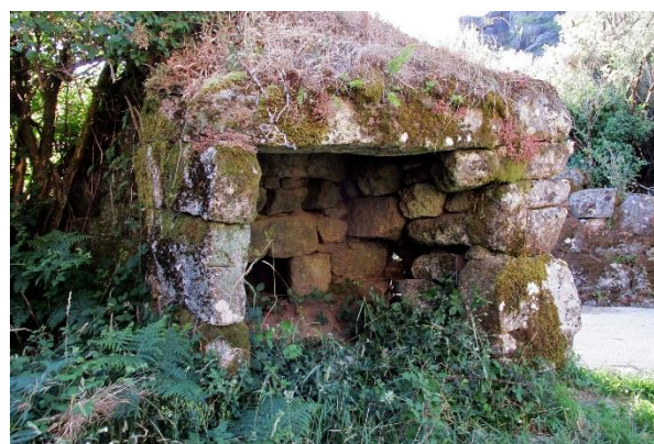
Fig. 9: Forno de Ramisqueira (vista Nordeste)
