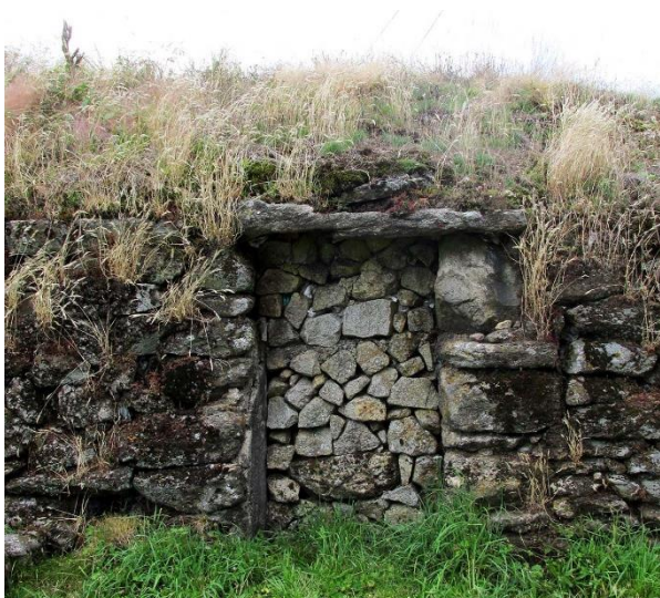
Fig. 33: Forno de Queimadelo (exterior)
