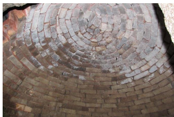
Fig. 2: Cúpula da Forneca (interior)
