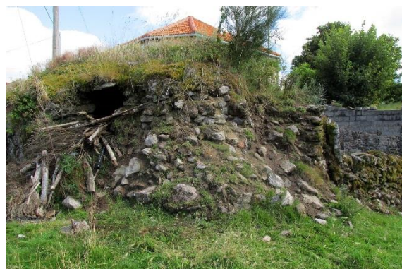
Fig. 36: Forno de Queimadelo (vista Norte)
