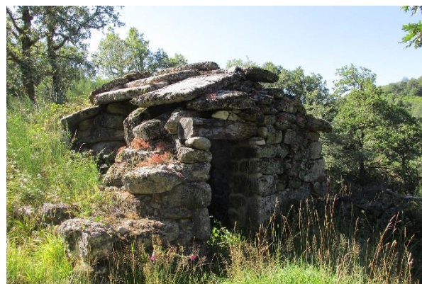
Fig. 5: Forno de Varziela (vista Este)
