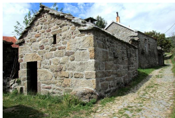
Fig. 29: Forno de Várzea Travessa (vista Sul)
