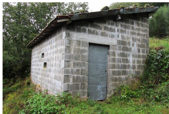
Fig. 24: Forno da Podre (vista Norte)
