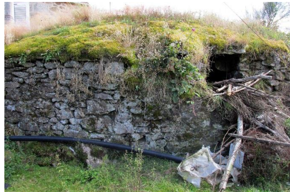
Fig. 35: Forno de Queimadelo (vista Norte)
