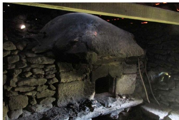
Fig. 3: Cúpula (estrutura exterior)
